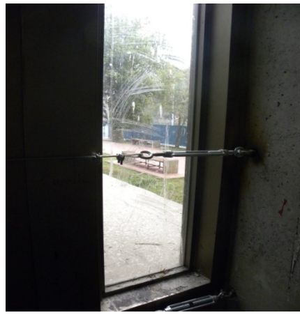
Anclaje de reja a ventanal principal
