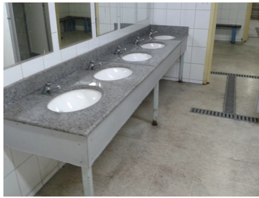
Llaves con corte automático de agua
