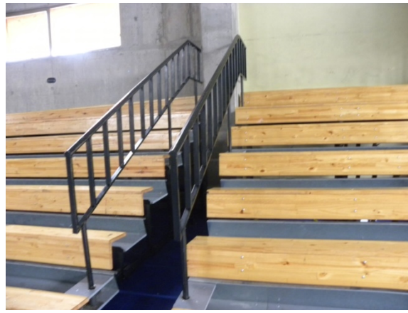
Separación de graderías por barandas
