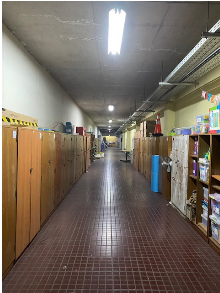
Pasillo Subterráneo Vista : Norte-Sur
