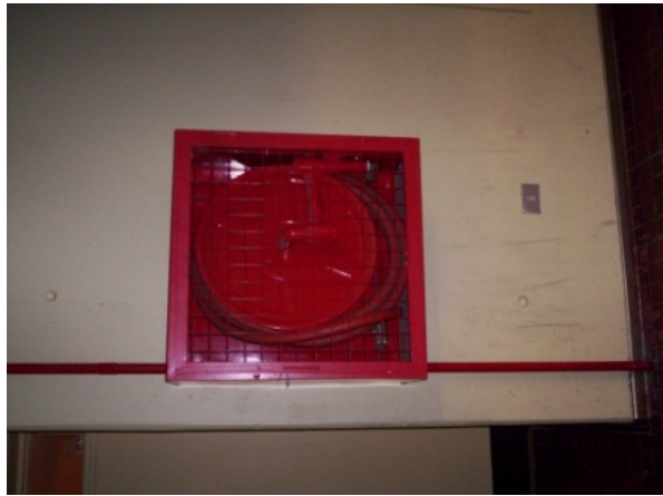
Manguera de aproximadamente 25 metros de longitud.
