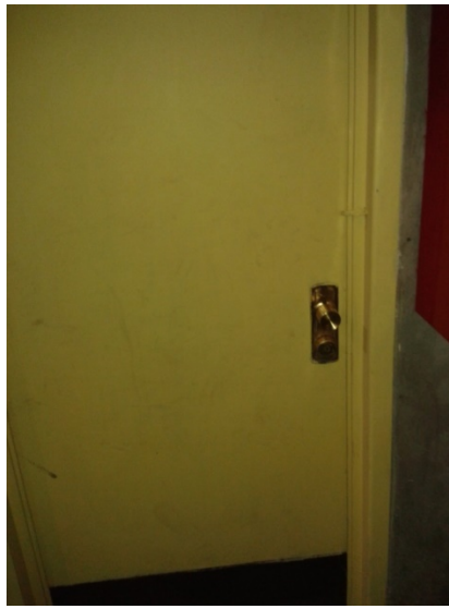
Puerta con cerrojo para ingreso a camarines damas y varones
