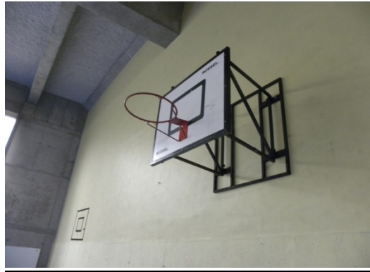
Aro de balón cesto empotrado a la pared lateral con soportes
