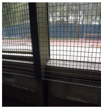
Protección de ventanal principal
