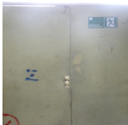
Salida de emergencia a patio de seguridad zona sur
