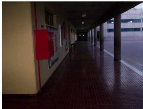
Pasillo 1er. Piso
