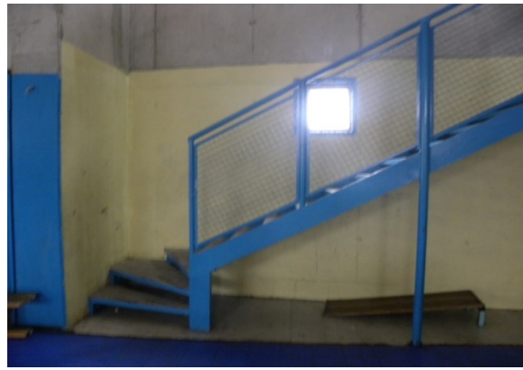
Escalera con pasamanos y reja de protección caídas Para subir a segundo piso
