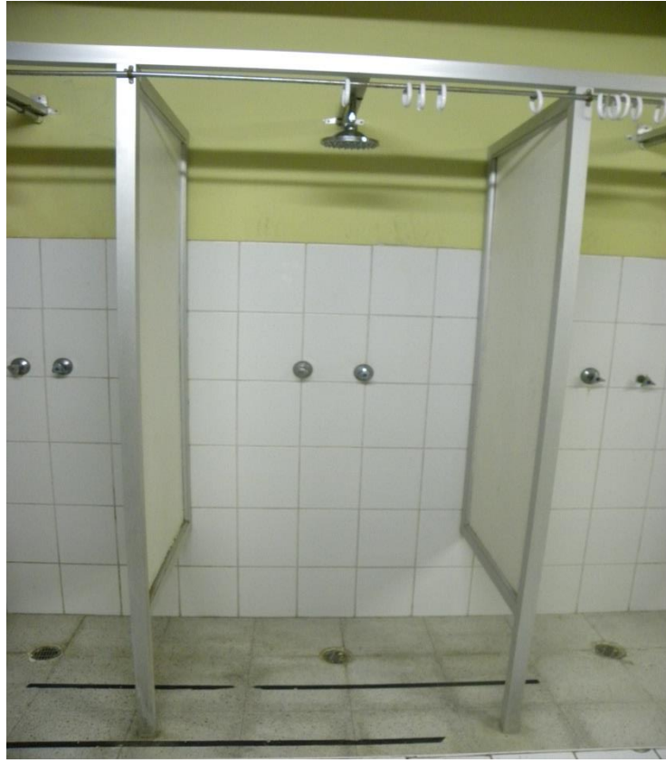
Camarines de damas con líneas antideslizantes en duchas damas y varones
