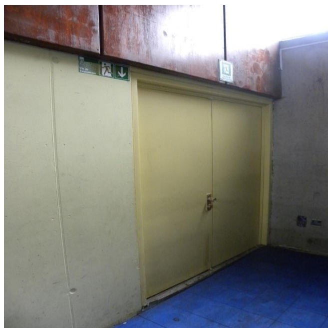
Salida de emergencia lateral zona oeste
