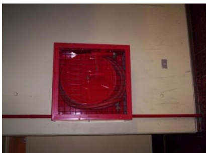
Manguera de aproximadamente 25 metros de longitud.
