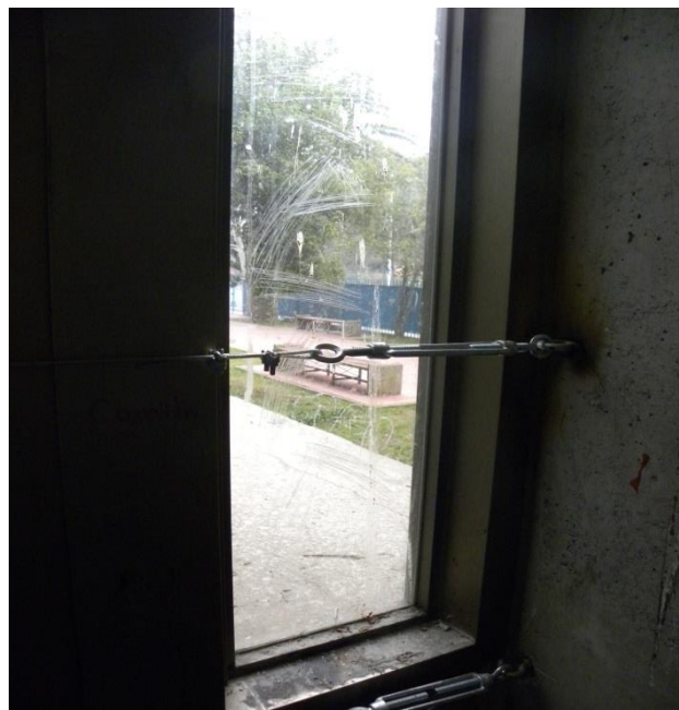
Anclaje de reja a ventanal principal
