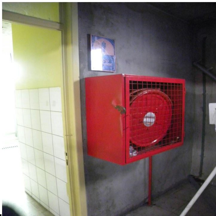
Red húmeda Manguera de incendio
