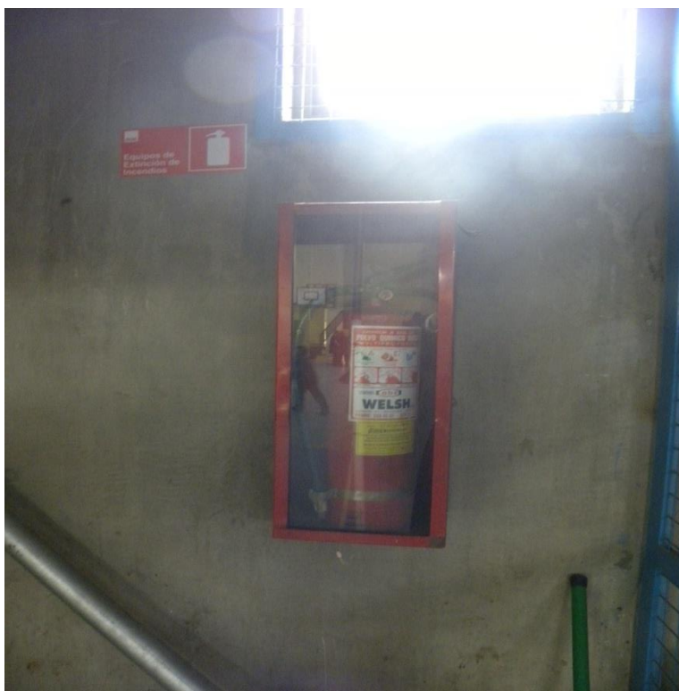
Extintor de incendio gimnasio
