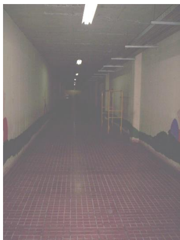
Pasillo Subterráneo Vista : Norte-Sur
