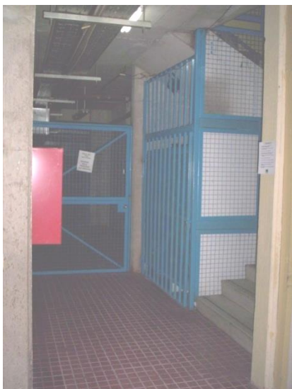
Grupo electrógeno en acceso a 1er. Piso
