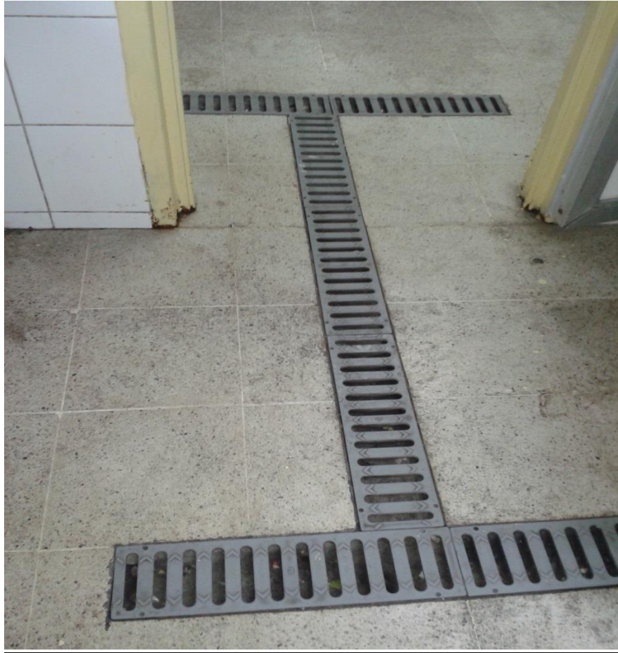
Sistema de evacuación de agua en camarines, damas y varones
