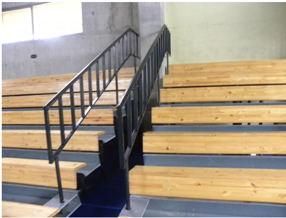
Separación de graderías por barandas
