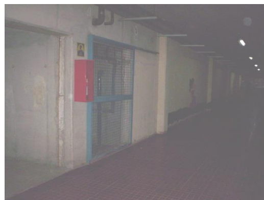
Bombas de agua en pasillo del subterráneo
