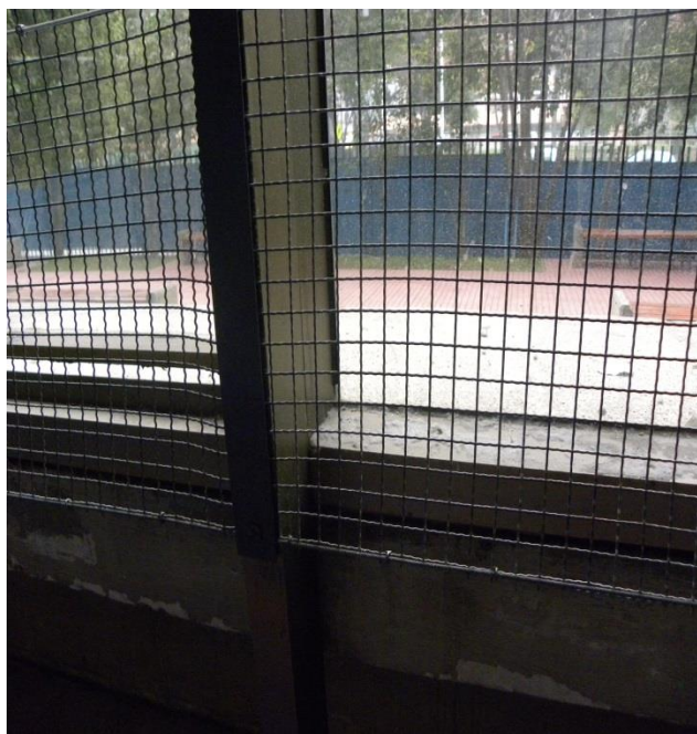
Protección de ventanal principal
