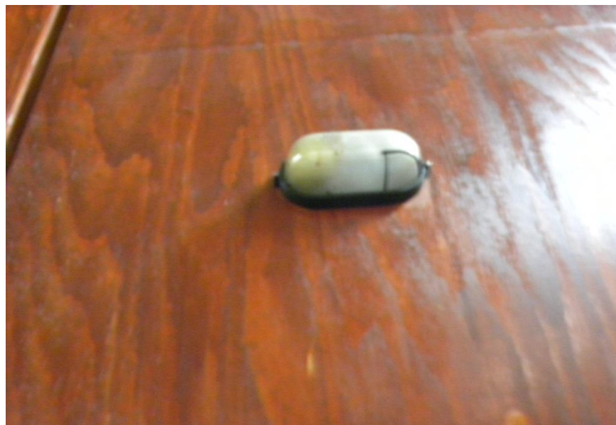
Luces de emergencia
