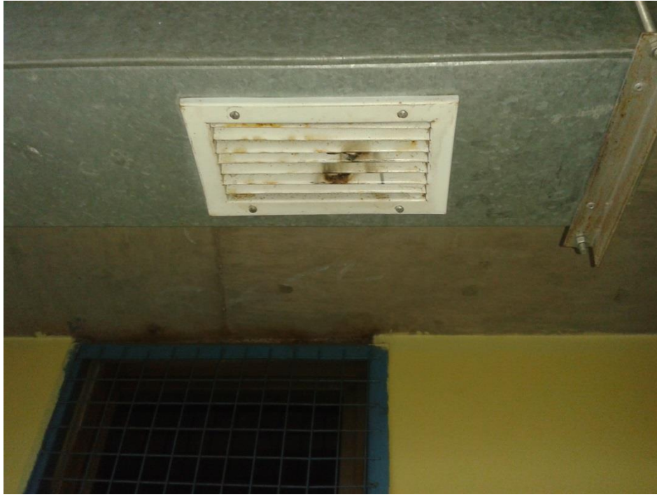
Evacuación de vapor de agua en camarines
