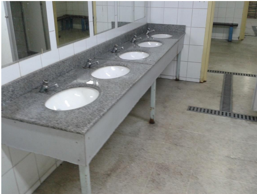
Llaves con corte automático de agua
