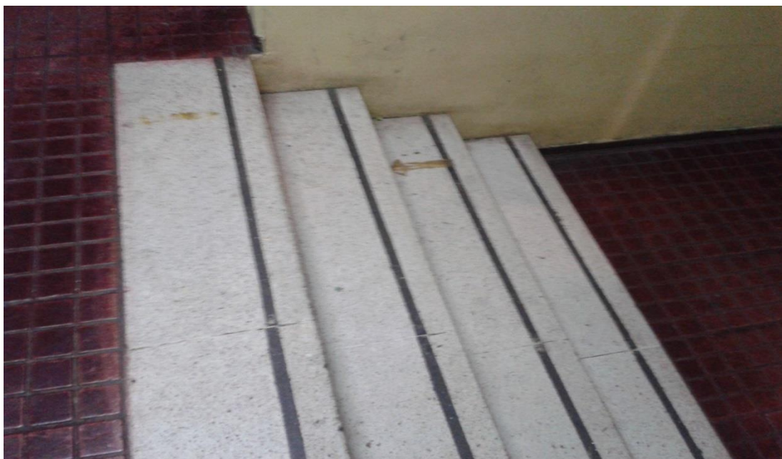
Escalera de ingreso con línea antideslizante
